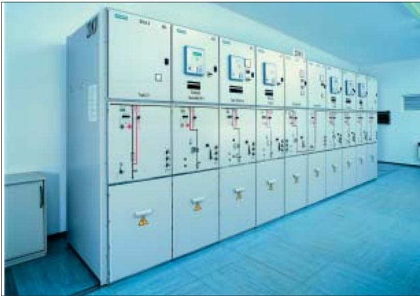
Bild 2: Schaltanlage NXplus C
