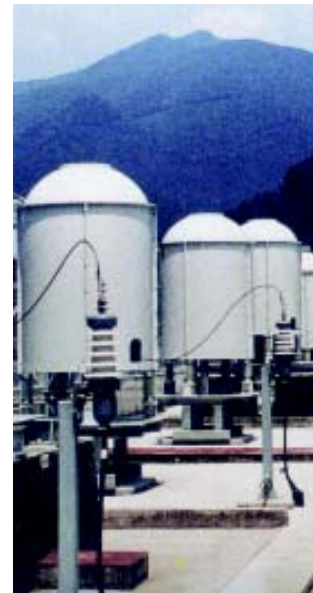
带声音屏蔽的滤波电抗器
