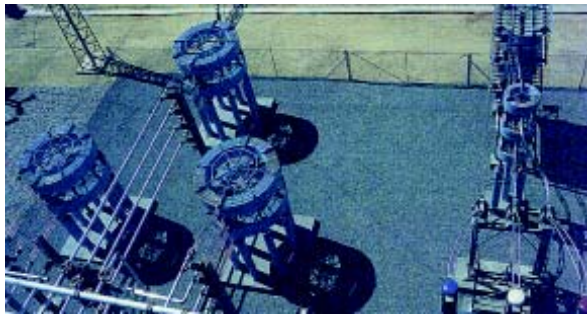
晶闸管控制的并联电抗器和滤波电抗器静止无功补偿
