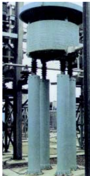
带升高座和顶盖的滤波电抗器
