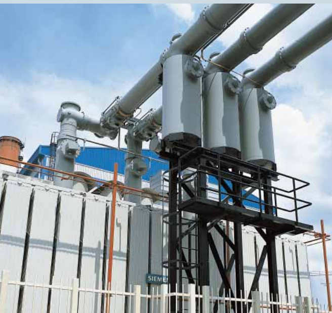
连接到420千伏GIS高压开关母线的GIS避雷器
