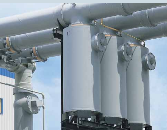
连接到420千伏GIS高压开关母线的GIS避雷器
